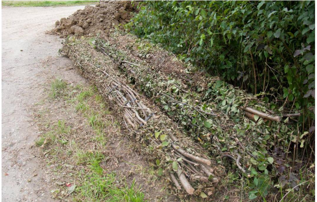
Einbauen einer toten Faschine quer zum Wasserlauf.
