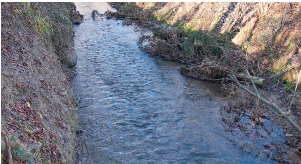
Im mittleren Bereich sorgen mehrere Raubäume für eine Stabilisierung des gegenüberliegenden Ufers.
