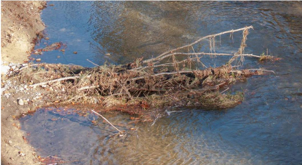
Laub- und Nadelholzpaket quer zur Strömung platziert. Hälfzig im Ufer verbaut, dort mit Akazienpfählen und Stahlseil gesichert und mit Wasserbausteinen beschwert.
