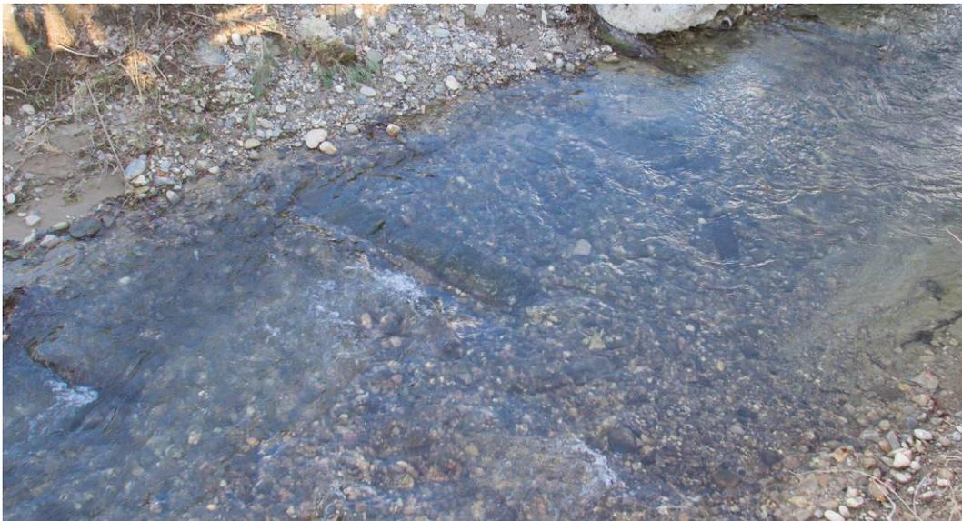
Die einseitig angeordnete Lenkbuhnen-Gruppe am Anfang des Erosionsufers führt längerfristig zu einer Ausprägung der Prallhangstruktur.
