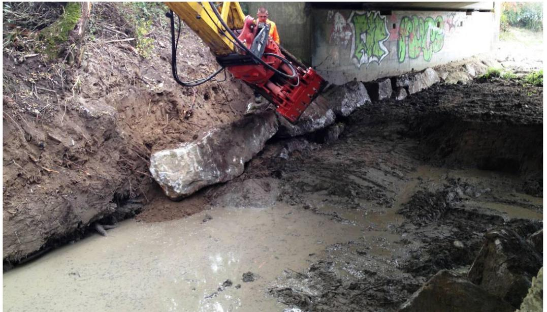
Die Lenkbuhnen sind hier nur zum Teil sichtbar, denn sie sind in das Ufer eingebunden.
