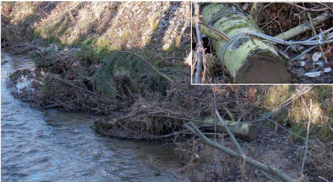
Weisstanne mit Wipfel in Strömungsrichtung. Nur am Stamm (Detail kleines Bild) mit Stahlseil an bestehendem Baum gesichert. Der Raubbaum kann bei Hochwasser driften.
