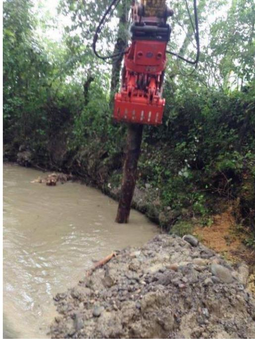
(v.o.l.n.u.r.): Aushub von steinigem Material. Eindrücken des cirka 5m langen Akazienpfahls. Drahtseil wird an Wurzelstock fixiert. Mit Greifer wird Wurzelstock unter Wasser gehalten und mit dem Stahlseil am Akazienpfahl fixiert (Fotos: Franz Bucher).
