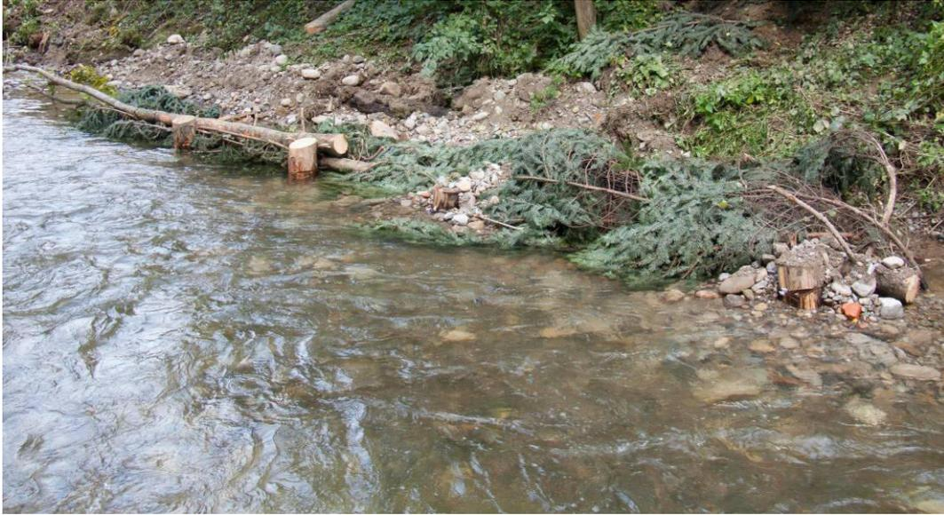
Laub- und Nadelholz-Paket als Ufersicherung und Strukturelement. An zwei Punkten mit Akazienpfählen und Stahlseilen starr fixiert.
