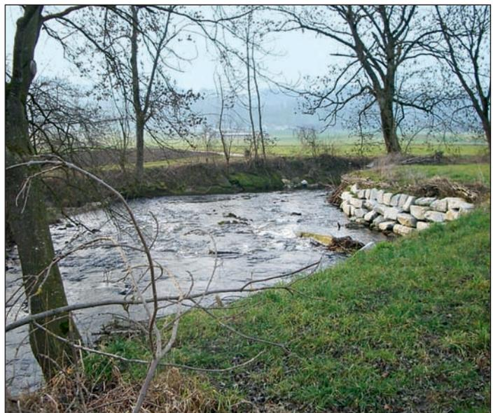
Foto 3: Dieser Bereich wurde im Sommer 2006 durch eine konventionelle Uferverbauung mit Steinen gesichert.
