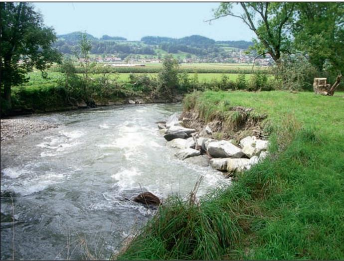
Foto 5: Situation nach dem Hochwasserereignis vom August 2007; die Mauer am Prallufer ist zerstört.
