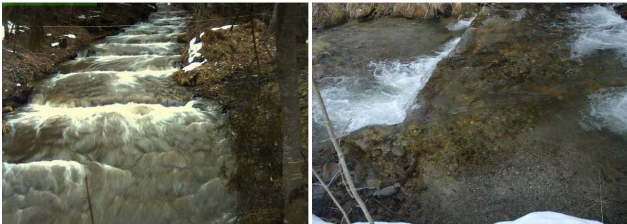
Abb. 5 Schmelzwasserabfluss bei der Pendelrampe am 25.03.2010, 18:27 MEZ (links), Substratsortierung in der 4. Riegel-Becken-Einheit der Rampe (rechts)
